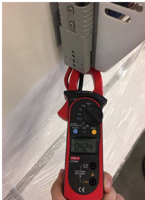
Kompressor fungerer ikke
