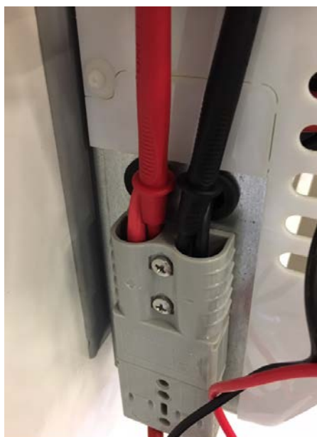
Mål på klemme (husk polaritet rød + / svart -)
